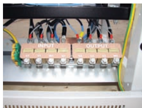
Oberon Y45-15: клеммная колодка для силовых кабелей
