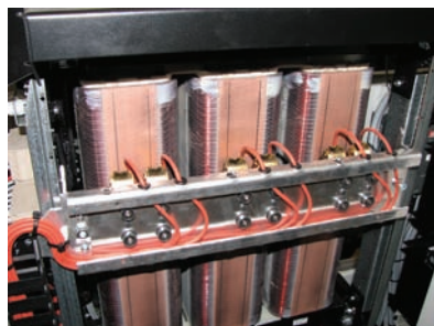
Трехфазный вариатор в сборе
